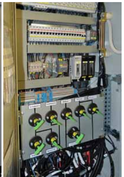
Hauptverteiler 24 V
