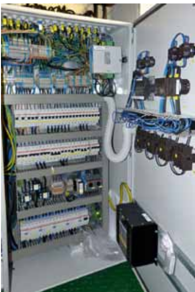
Hauptverteiler 400/230 V
