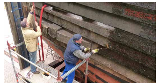
Anstrich des Überwasserschiffes
