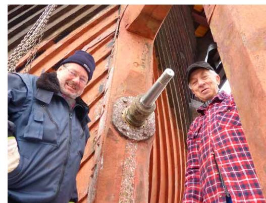
Neue Dichtringe im Stevenrohr
